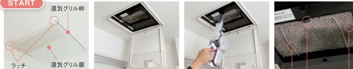
**はじめに** お手入れは、必ずセントラル換気扇専用スイッチを「切」にしてから行って下さい。お手入れの際は、安定した台を使用するか、脚立を正しく利用下さい。
