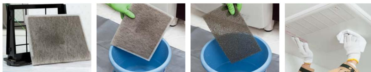
**10** フィルターAssyの枠から外気フィルターを外し、ハンディクリーナーでホコリを除去します。汚れがひどい場合は、水または中性洗剤を入れたぬるま湯で軽く押し洗いし、自然乾燥させます。フィルターが傷むため、もみ洗いや絞りも避けず、フィルターに損傷がある場合は新品と交換してください。
