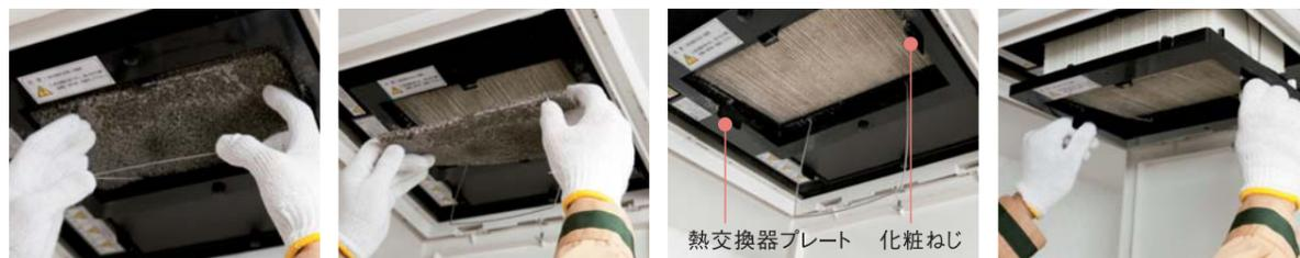
**3** 「還気フィルター用止め金具」を曲げて「引っかけ」から外し、還気フィルターを外します。
