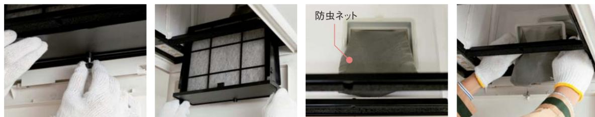
**5** フィルターAssy本体を押さえて化粧ねじを取り、フィルターAssy本体を外します。
