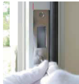
3 ストライクの上下のネジをぐらぐらにならない程度に(半回転)ゆるめ、鎌式デッドボルトがスムーズにかかる位置までストライクをずらし、ネジを締め固定します。 ※ストライクのネジは絶対にはずさないでください。
