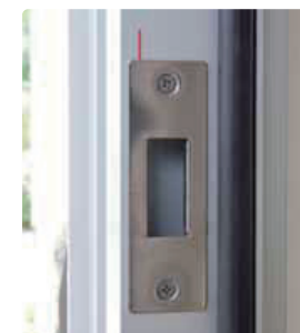
2 長年の使用や、鍵が開まっているかどうかを確認する(ドアをガチャガチャさせる)行為で、その位置がずれてきます。
