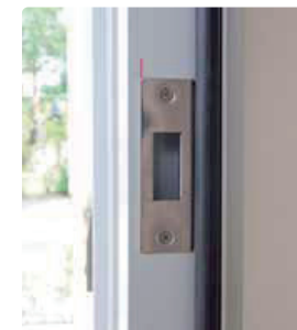
1 玄関ドアのストライクは鎌式デッドボルトがかかる位置に設定されています。
